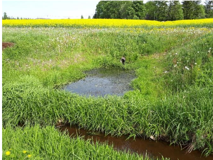
Joonis 2.33. Suudmelodu 10 m laiusel veekaitsevööndil Rahinge oja ääres
