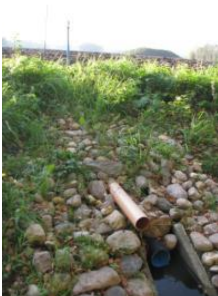
Joonis 2.44. Pöördklapp koos ülevooluga Pärna 1 ehitisel 2010. aastal
