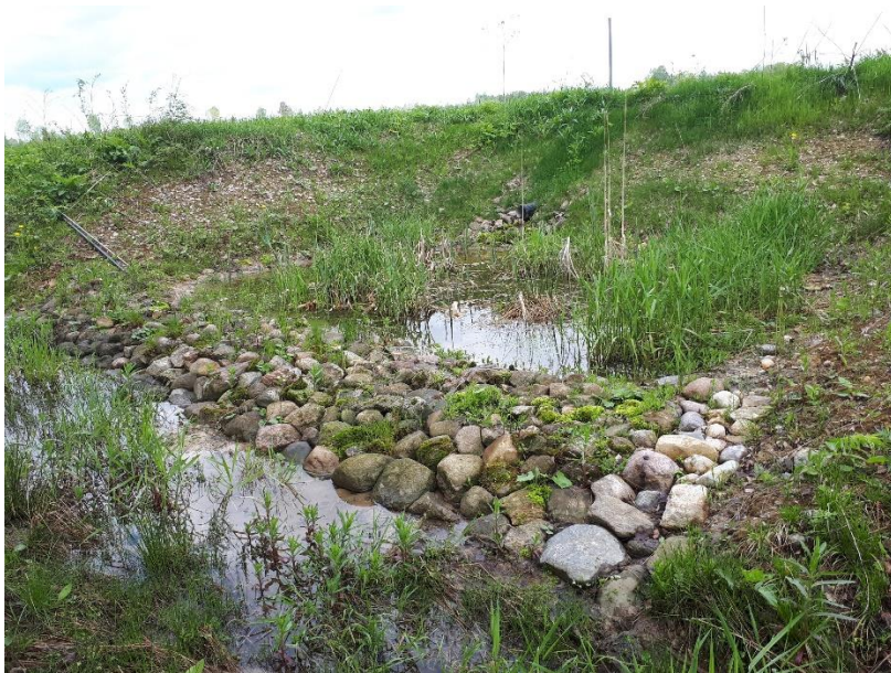
Joonis 2.39. Suudmelodu ehitisel Kokavälja II.
