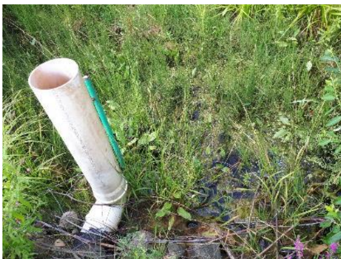
Joonis 2.45. Suudmes ülesse pööratav paisutustoru Lemme ehitisel.
