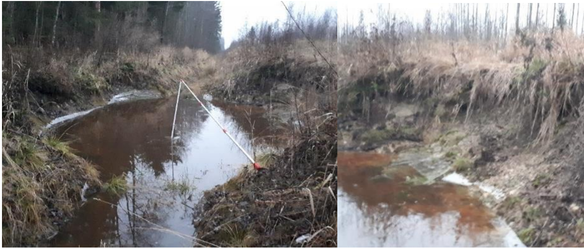
Joonis 2.6. Settebasseini nõlva voolamine saviliivpinnases (Võtikvere).
