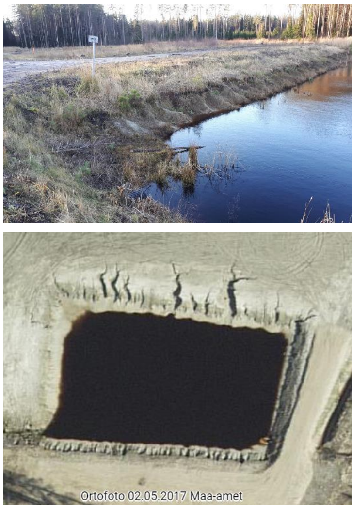
Joonis 2.56. Nõlva erosioon liivapinnases Pikanõmme (6 112 350 010 010) ehitisel (fotod 2021 sügis ja 2017 kevad).
