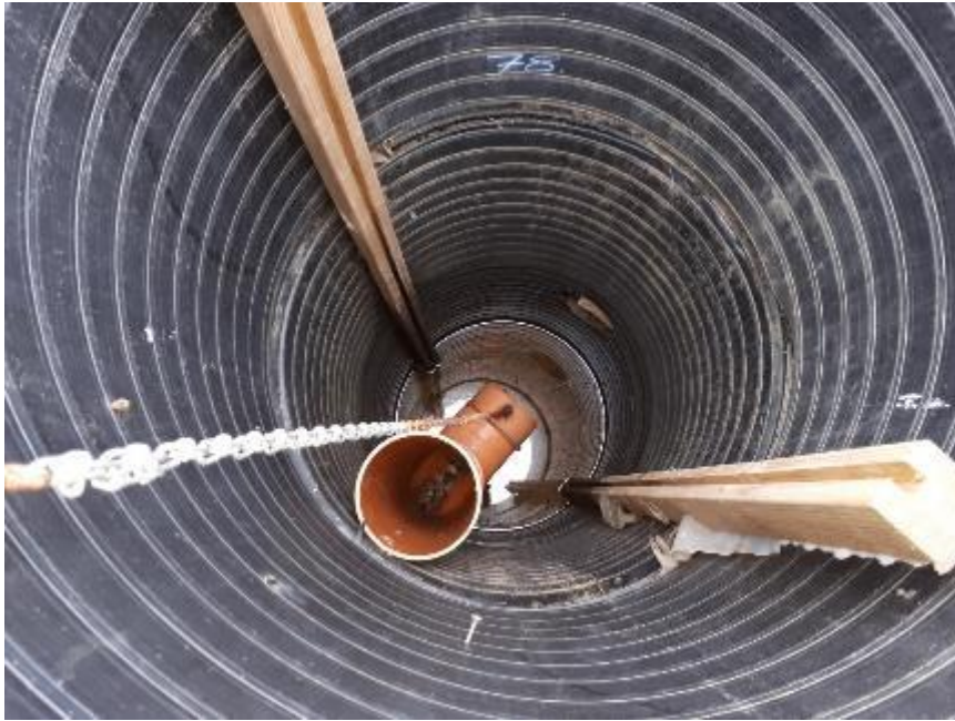
Joonis 2.47. Rekonstrueeritud seadedrenaaži kaev Lemme ehitisel.
