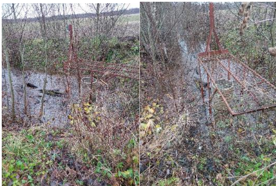
Joonis 2.51. Pärnumaa Tuudijõe maaparandusehitise seadedrenaazi regulaatorkaevud
