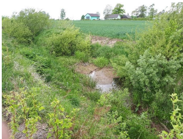
Joonis 2.15. Põlva maakond, Habemiku talu Ibaste ehitise täis settinud puhastuslodu.
