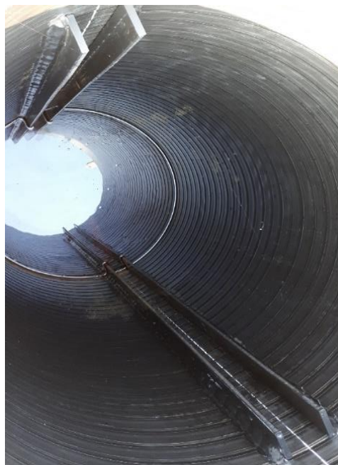
Joonis 1.5. Põlendmaa seadedrenaazi reguleerimiskaev.
